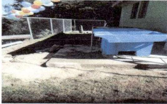
Foto 1: Colocación de torta de concreto y sustitución de pila.
