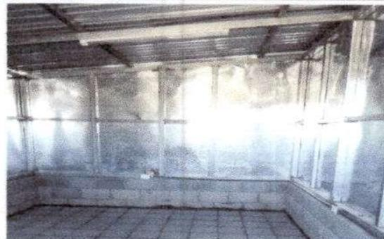
Foto 4: Sustitución de muro de madera por lámina en bodega.
