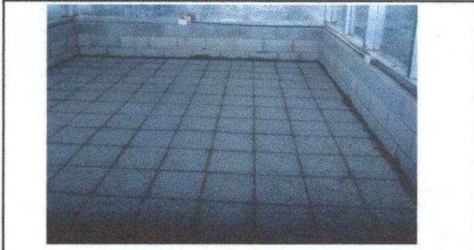
Foto 7: Sustitución de torta de concreto por piso de granito en bodega.
