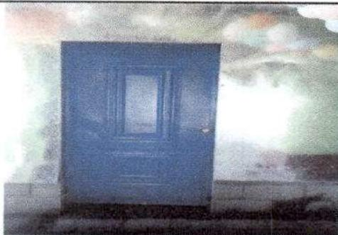
Foto 5: Sustitución de puerta de madera por metal en bodega.
